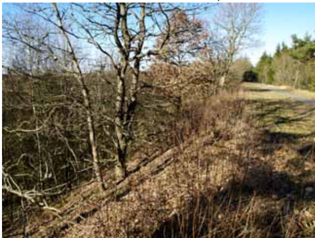
Dæmningsanlæg nord for Vrads Station
