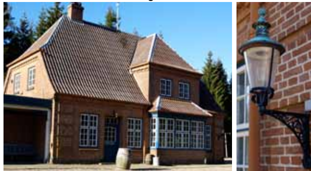
Vrads Station og detalje af udvendig lampe
